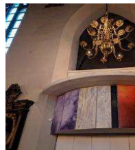
Dieser Vorbau wird verschwinden, die Nordkapelle historisch wiederhergestellt.
